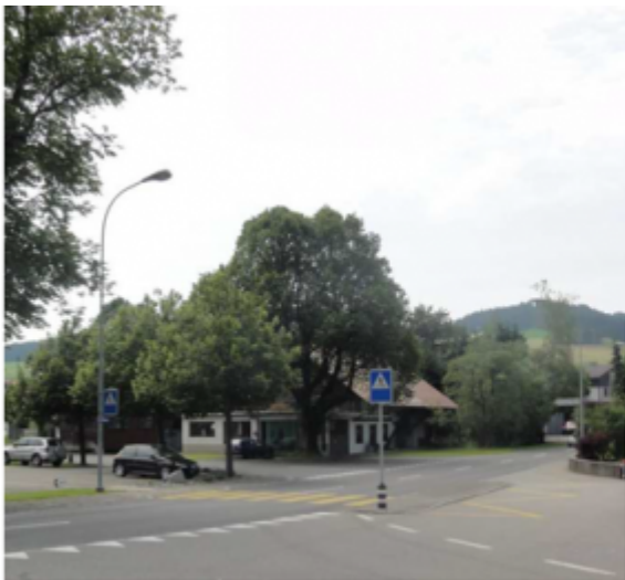
Vor der Sanierung
