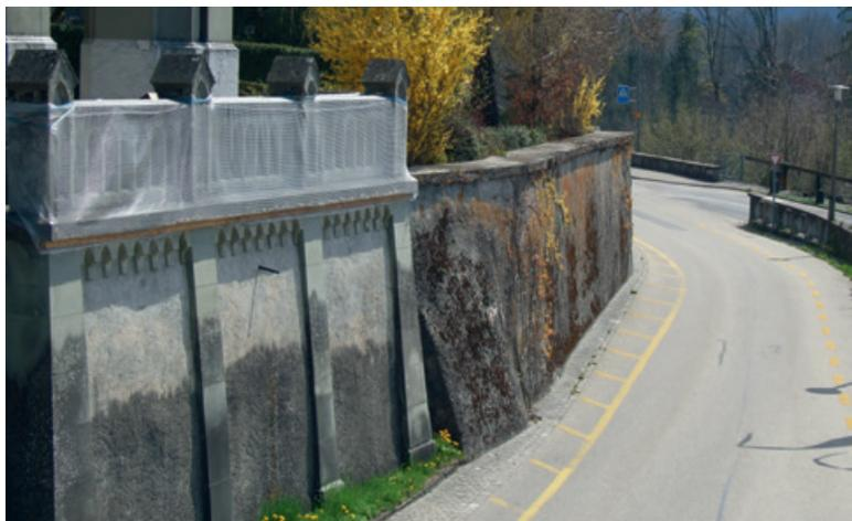
Jahren beobachten wir mit grosser Sorge die Risse bei der Frontseite des Turmes und die Ablätterung des Belages sowie die Risschäden der Stützmauern auch die Senkungen beim Vorplatz des Kircheneinganges. Die fortschreitende Zunahme der Schäden wird in naher Zukunft zu einer Sanierung dieser Gebäudeteile führen. Die Sanierung des eingepackten Sandsteingeländers wird anfangs Sommer in Angriff genommen.
